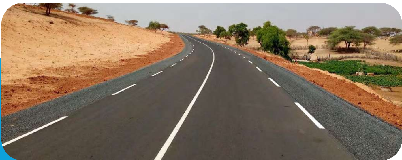
Photo 1 : Construction de la route des Niayes
